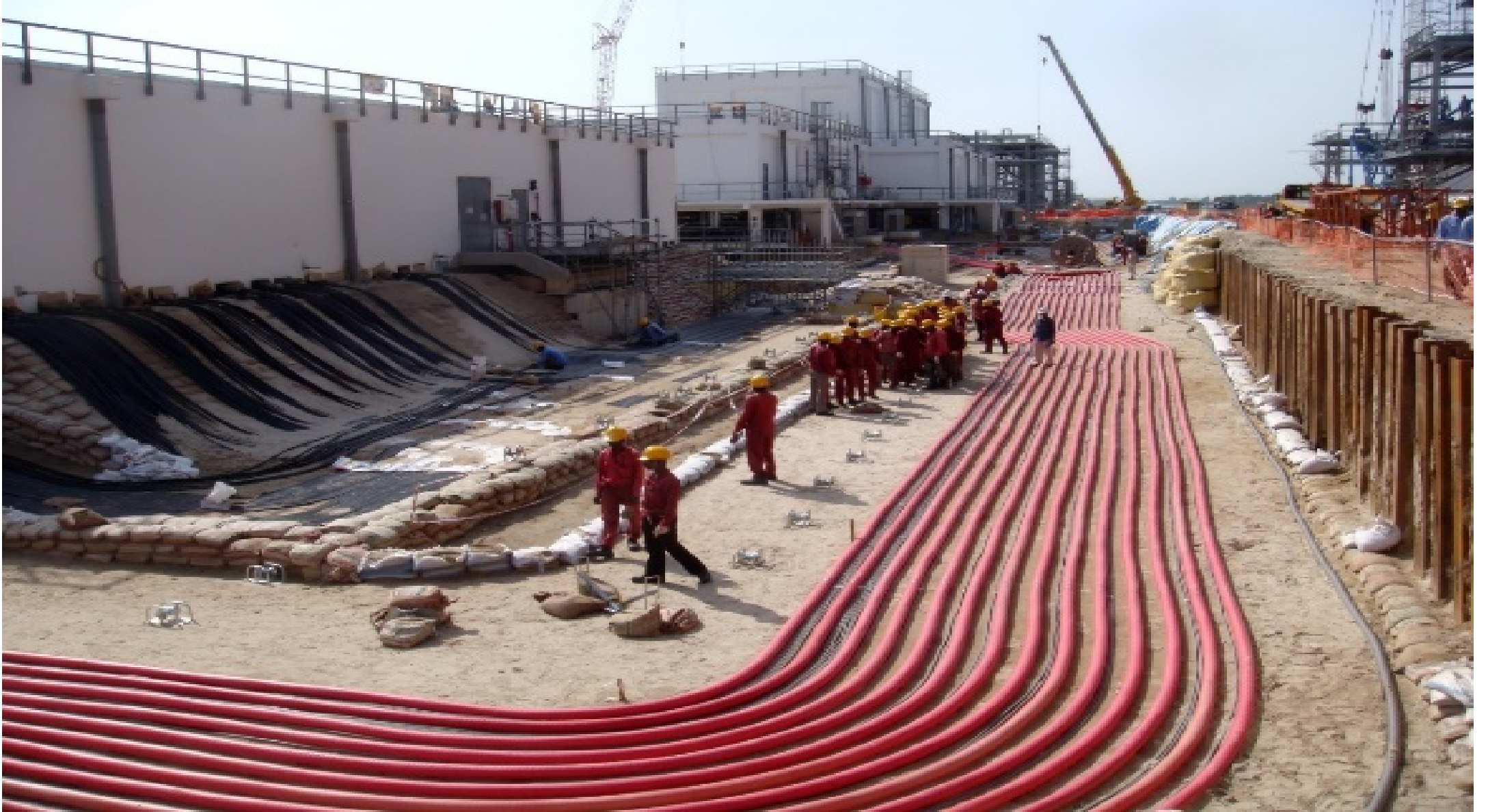
Yeraltı Elektrik Kablo montajı.
