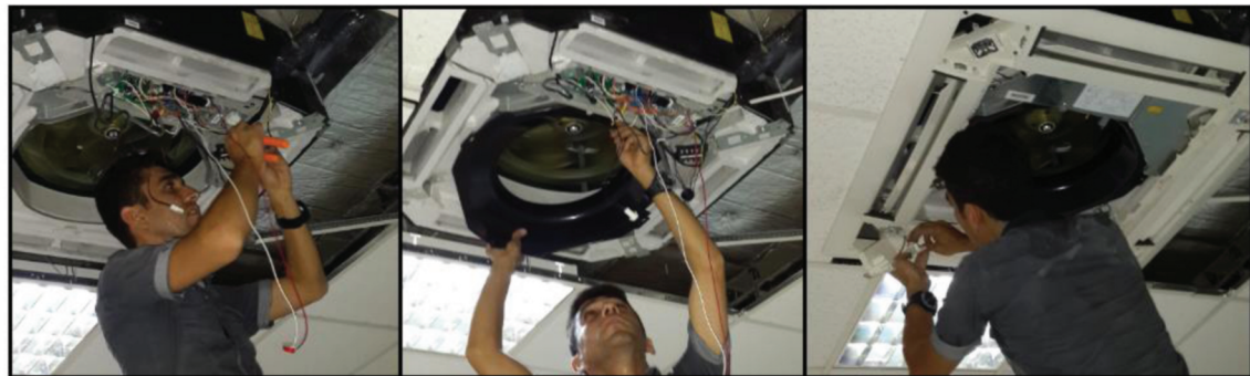
Şekil 9. Temizliği Biten ve Kurulanan Parçaların Yerlerine Montaj Edilmesi
