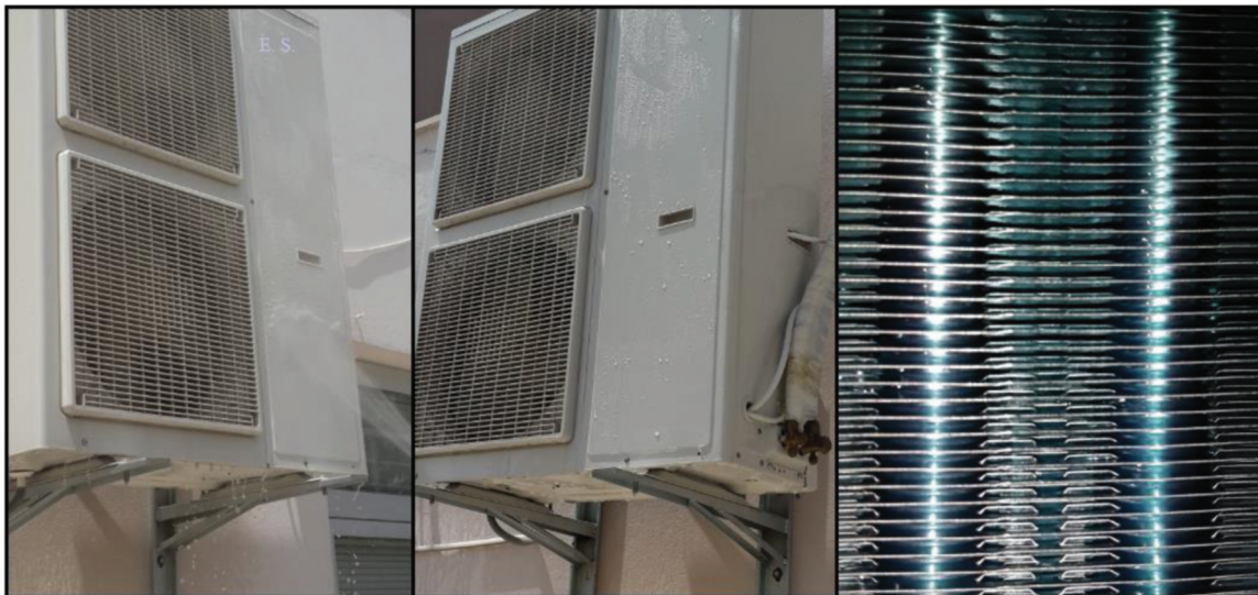
Şekil -12 Bakımı Yapılmış Dış Ünite ve Temizlenmiş Dış Ünite Serpantinleri
