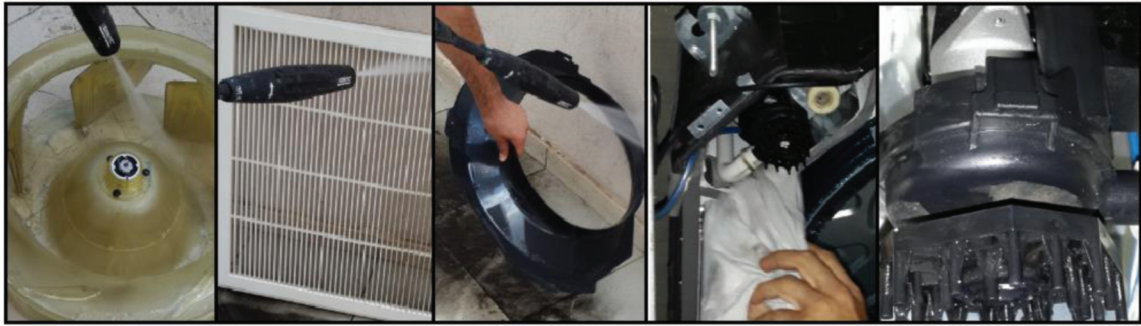
Şekil 8. Fan, Panjur, Fan Koruması, Su Tavası ve Pompa Kanatçıklarının Temizliği
